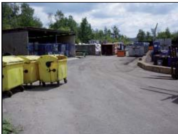
Obr. č. 3: Třídící linka nebezpečného odpadu (bývalá) dekontaminační plocha
