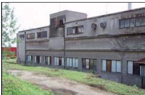
Obr. č. 4: Objekt č. 24 (bývalá poloprovozní hala)
